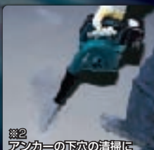
※2 アンカーの下穴の清掃に
